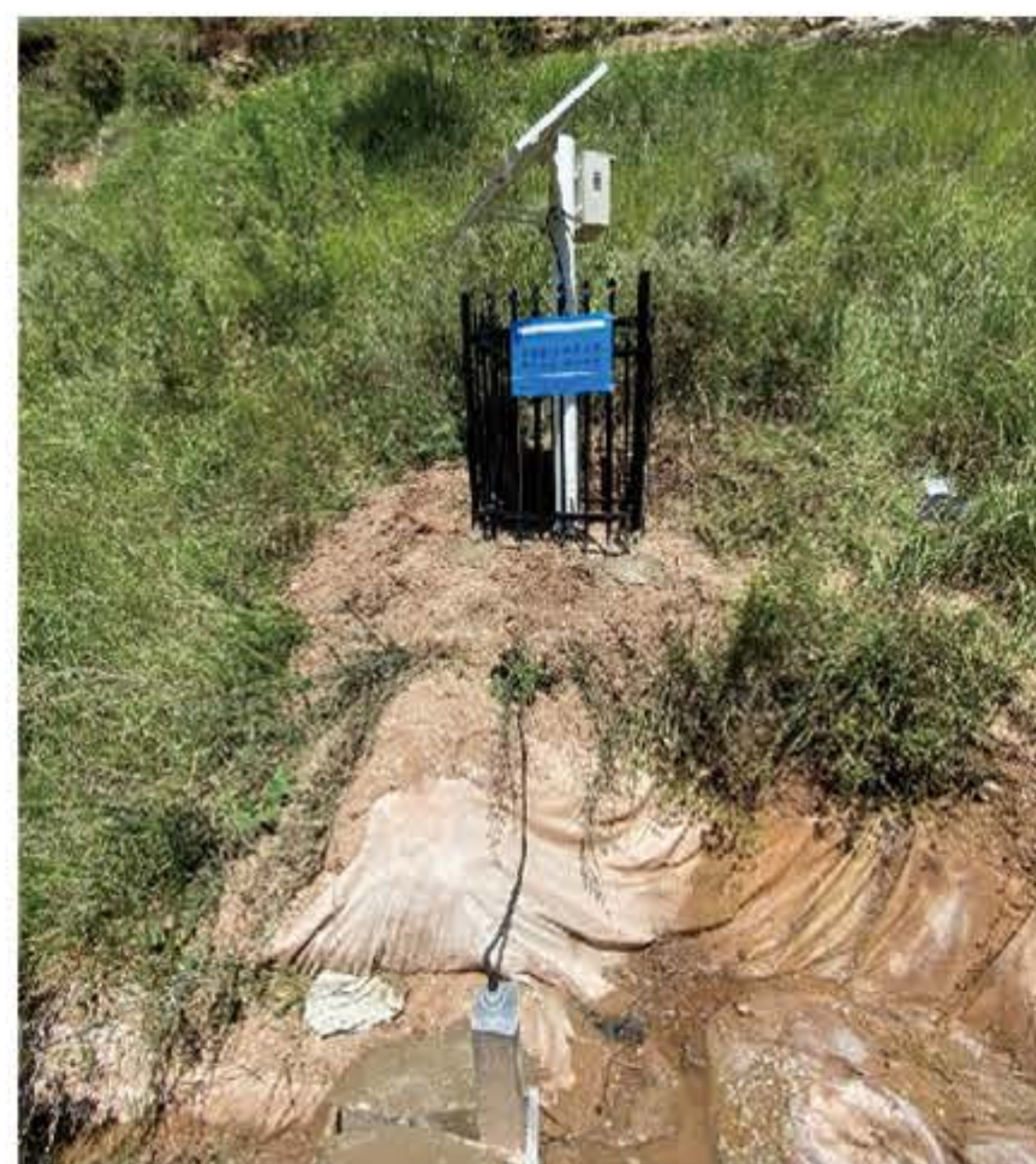
西宁市南川东路边坡监测
