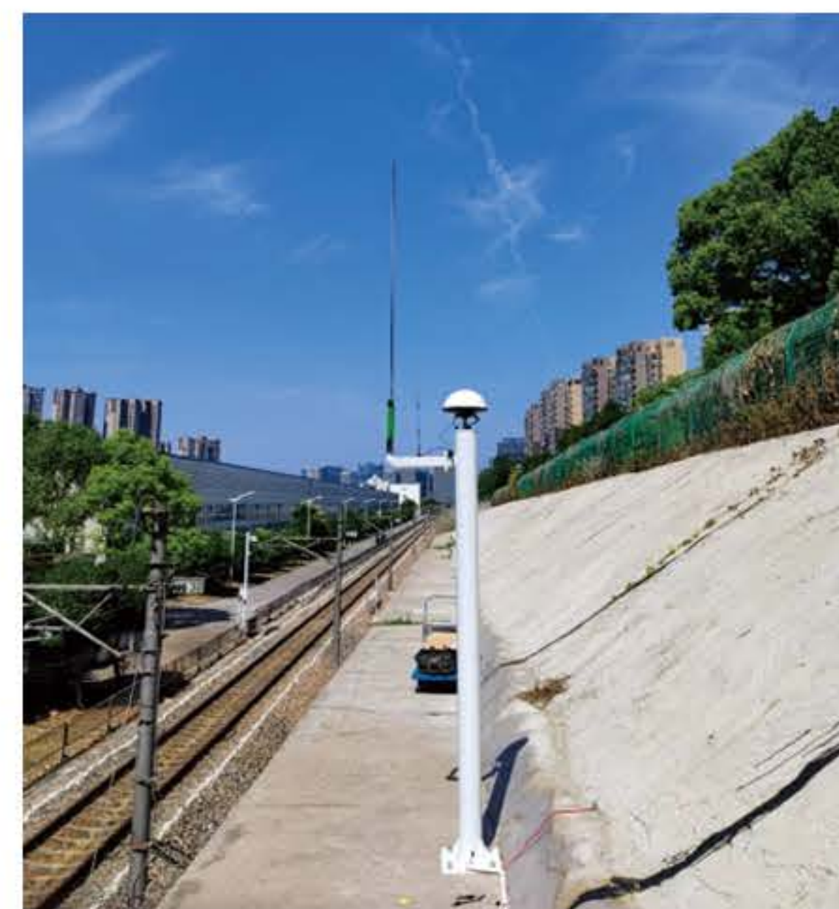
南京地铁边坡监测
